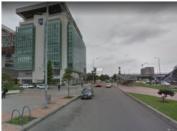
Ilustración 11. Principal acceso peatonal al IDEP Fuente: Google Maps.
