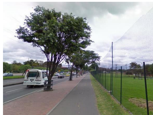
Ilustración 6. Ciclorruta Av. Carrera 68 Fuente: Google Maps
