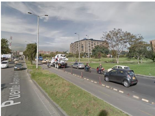
Ilustración 9. Ciclorruta Av. Carrera 50 Fuente: Google Maps
